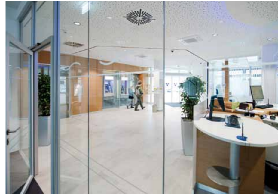
▲ Rauchdicht abgetrennt ist der Treppenaufgang von der Kundenhalle
