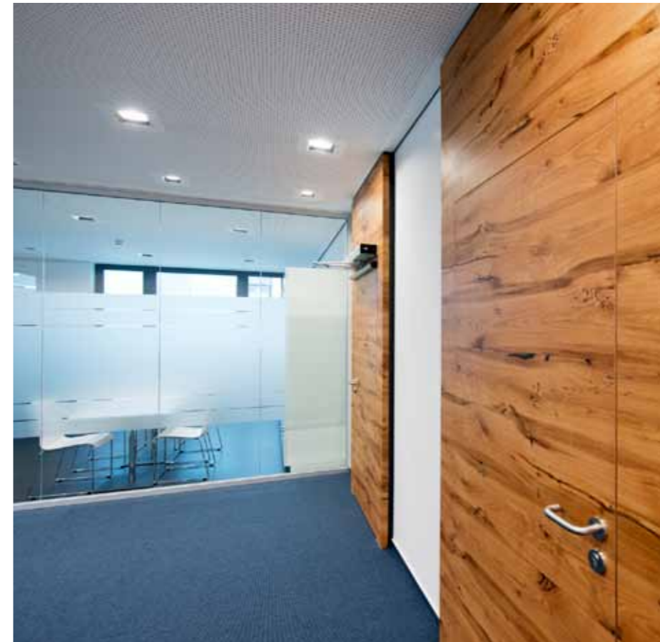
▲ Die Brandschutztüren sind ebenfalls in Eiche Altholz furniert
